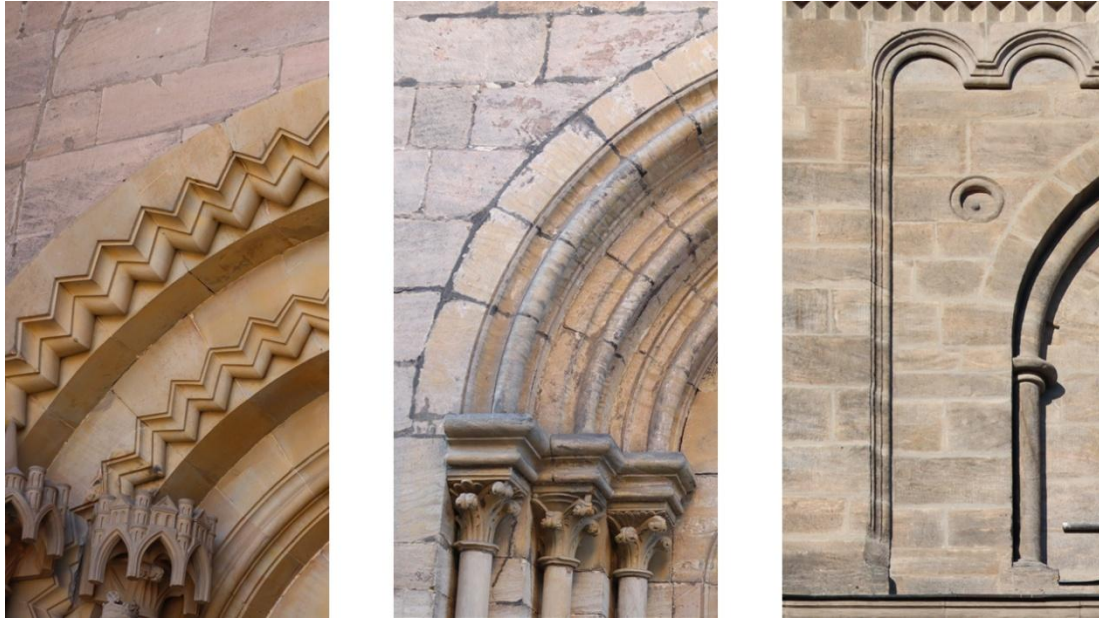
Figure 8 : L'utilisation du profil du portail sud de Conques dans les archivoltas de l' Adamsporte (à gauche), de la Veitsporte (au milieu) et des bandes lombardes des clochers orientaux (à droite) à Bamberg.
