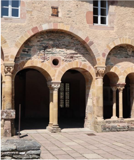
Abb. 39: Portal des Kreuzganges von Conques (links). Dieses Portal ist das vermutlich früheste bekannte Beispiel eines Koppelportals bzw. Koppelfensters mit Überfangbogen und Oculus im Zwickel. Allenfalls sind die vergleichbaren westlichen Emporenfenster von Gernrode noch älter. Deren Datierung ist jedoch nicht ausreichend gesichert. Die ikonische Westfassade von Conques (rechts) nimmt mit ihrer byzantinisch inspirierten Umrahmung des Doppelfensters mit Oculus erstmals das gotische Gruppenfenster vorweg. Ähnliche Fenstergruppen existieren auch an den Querhäusern. Die Verwendung des Doppelfensters mit Oculus ist in Conques ähnlich außergewöhnlich prominent wie in Bamberg. Zusammen mit Fenstern von Moissac und Toulouse sind die Emporen- und Kreuzgangfenster von Conques die frühesten erhaltenen Fenster mit Doppelsäulen.
