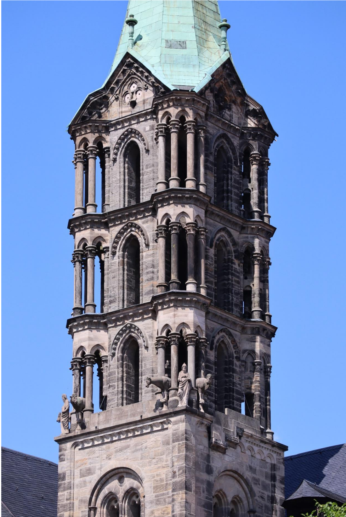
Abb. 60: Südwestturm des Bamberger Doms mit drei Tabernakelgeschossen. Die Bögen der Tabernakel des unteren Geschosses haben eine deutlich niedrigere Lage als die des obersten Geschosses. Dadurch haben die unteren Tabernakel eine massive Mauerkrone (wie in Palermo), die oberen wirken filigran (wie in Laon). Das mittlere Geschoss stellt einen Zwischenzustand dar. Die Ausgestaltung der Tabernakel folgte dem Vorbild von Laon. Der Giebelkranz und der Helm des Turms stammen aus der Barockzeit.
