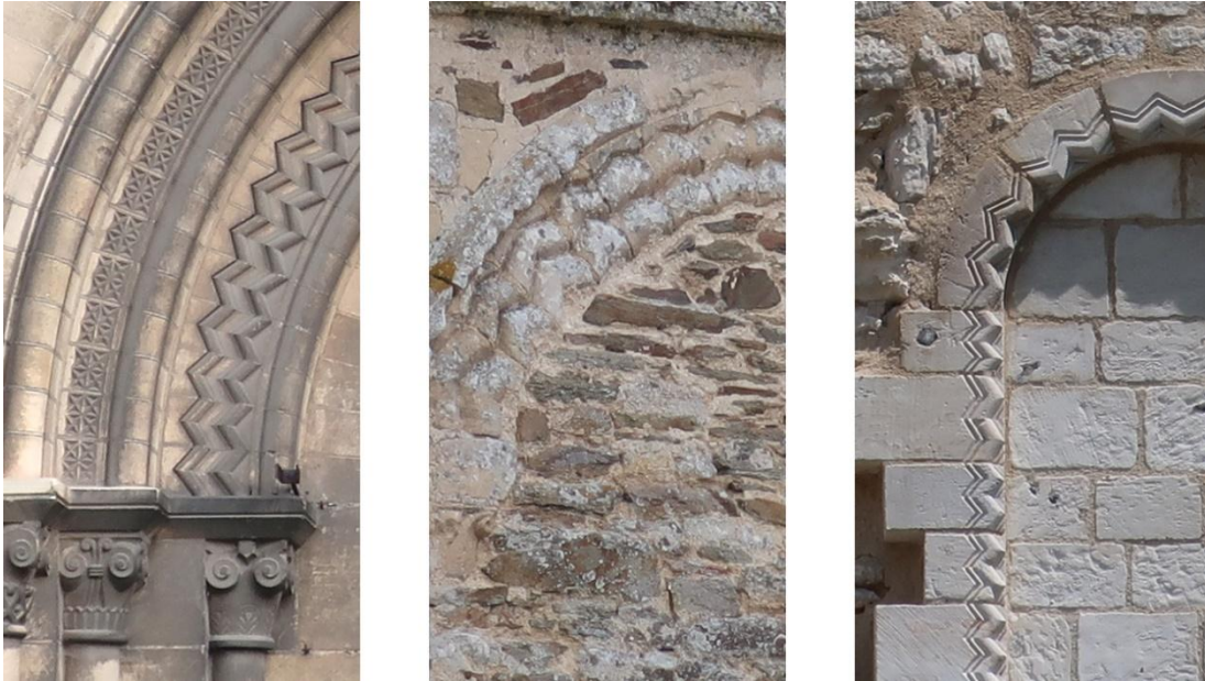
Abb. 51: Typische Zickzackbögen der Normandie in Caen (Sainte-Trinité, links), Cerisy-la-Forêt (Mitte) und Jumièges (rechts). Im Gegensatz zu Brioude, Le Puy-en-Velay und Bamberg weisen normannische Zickzackbögen in der Regel mehrfache gebrochene Rundstäbe auf. Bisweilen befindet sich auch eine ausgeprägte Kehlung zwischen diesen (links). Die Ausprägung in Jumièges (rechts) ist praktisch identisch mit dem Nordportal von Schlettstadt. Ansonsten dominierten im Reich einfache gebrochene Rundstäbe, wie bei Brioude oder St. Theodor in Bamberg. In Caen (links) findet man zusätzlich den römisch-normannischen Rautenfries mit Trennstegen zwischen den kreuzförmigen Sternelementen.
