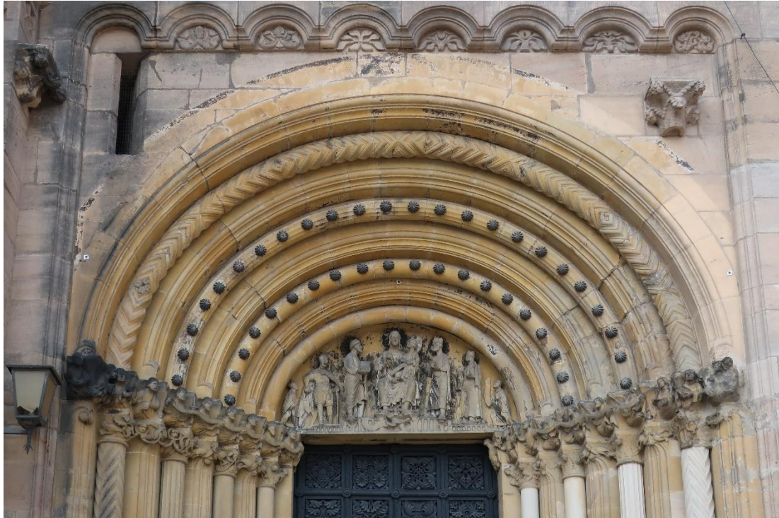
Abb. 7: Bamberger Gnadenpforte mit vier eingestellten Säulengruppen, die jeweils aus zwei, teilweise kannelierten Säulen in den Gewänden und einem identisch kannelierten Rundstab in den Archivolten bestehen. Die Profilkanten der Gewändestufen sind gekehlt und ebenfalls kanneliert. Zwei Rundstäbe tragen Zierkugeln (Sterne). Über den Kapitellen der Säulen befinden sich Büsten der Apostel in der Tradition ornamentaler Kämpfer. Am oberen Bildrand kann man die Blattfüllungen des profilierten Bogenfrieses erkennen.
