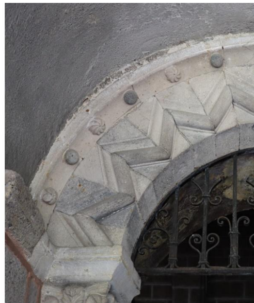
Abb. 50: Strukturell nahezu identische Zickzackbögen der Adampforte in Bamberg (links) und aus dem Kathedralkomplex von Le Puy-en-Velay (rechts). In beiden Fällen bestehen die Bögen aus einer gebrochenen Kehlung mit äußerer Profilstufe und einem abgesetzten, gebrochenen Wulst oder Rundstab. Die Grundstruktur dieser Zickzackbögen entspricht ebenfalls der Archivolt des Südportals von Conques oder der äußersten Archivolt der Porte des Comtes in Toulouse. Eine dritte Ausprägung dieses sehr seltenen Zickzackbogens existiert in Vilar de Donas, kurz vor Santiago de Compostela. Die Archivolt in Le Puy-en-Velay (rechts) enthält in einer zusätzlichen Kehlung Zierkugeln, von denen einige nahezu identisch mit den Ziersternen der Bamberger Gnadenpforte sind. Sie weisen lediglich spiralförmig gebogene Strahlen auf, ähnlich wie bei Spiralgalaxien.
