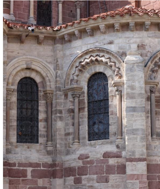
Abb. 49: Zickzackbögen des vermauerten Westportals von St. Theodor in Bamberg (links) und der nördlichsten Radialkapelle von Saint-Julien in Brioude (rechts). In beiden Fällen wurde der Zickzackbogen als gebrochener Rundstab realisiert. In Bamberg erfolgte dies nur andeutungsweise. Die Ausprägung bei St. Theodor ist typisch für die meisten der wenigen Zickzackbögen im Reich aus der Zeit vor dem Bamberger Dom (z.B. Worms). In den Zwickeln des Portals von St. Theodor (links) befinden sich zudem Darstellungen von Löwen, die nicht deutlich sichtbar in die Wand des Portals integriert sind. Sie sind als Vorläufer der Portallöwen des Doms zu betrachten.
