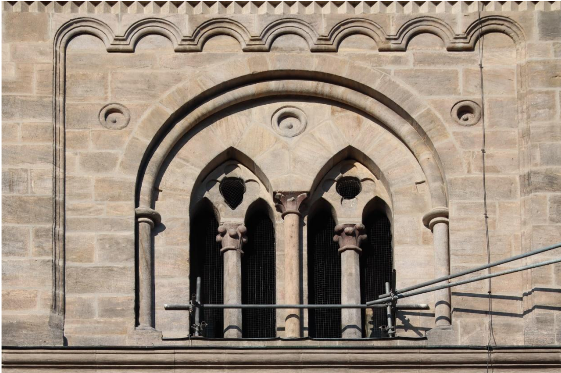
Abb. 65: Turmfenster des obersten Geschosses des Bamberger Nordostturms. Die oberen Geschosse der Osttürme stammen aus der letzten Bauphase des Doms. Die eingestellten Säulen und Rundstäbe sowie die Spitzbögen der Fenster dieser Geschosse waren vermutlich von Laon beeinflusst. Dagegen weisen die ungewöhnlichen Medaillons in den Zwickeln eher auf italienische Vorbilder hin. Insbesondere haben die großen Turmfenster des Campanile von La Martorana in Palermo Medaillons an vergleichbaren Positionen.
