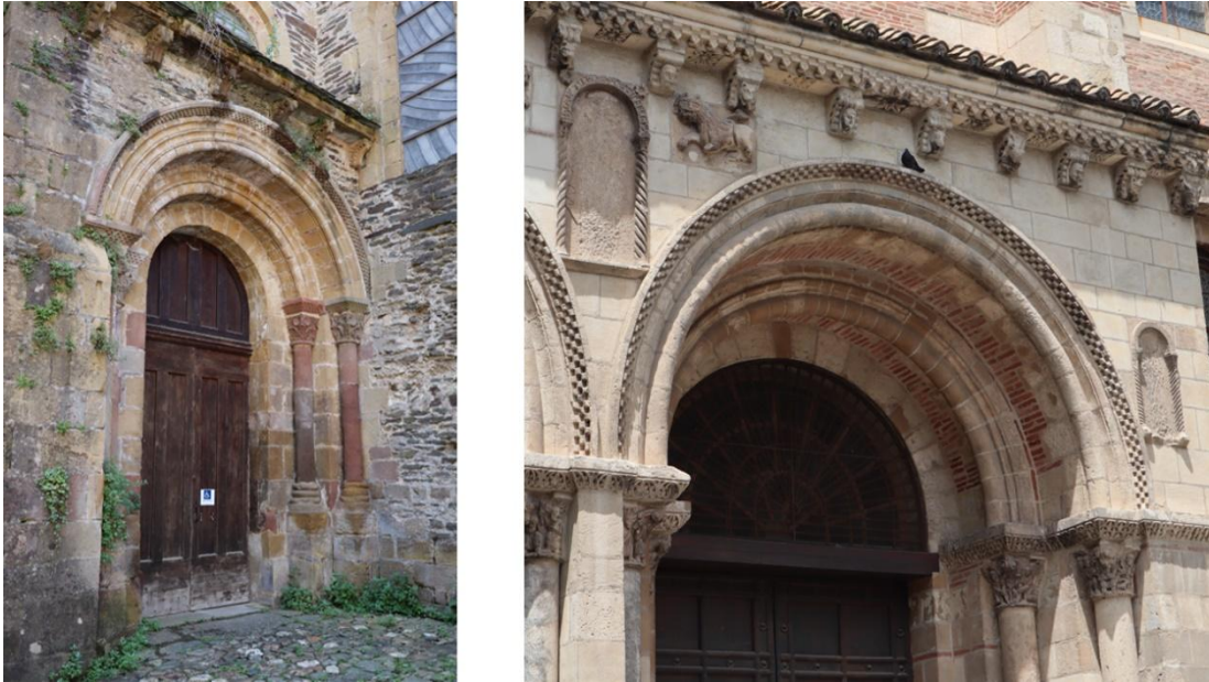
Abb. 35: Westportal des nördlichen Querhauses von Conques (links) und Details der Porte des Comtes in Toulouse (rechts). Die Querhausportale von Conques, die Porte des Comtes in Toulouse sowie die sehr ähnliche Puerta de las Platerías in Santiago de Compostela gelten als die frühesten erhaltenen Gewände- oder Stufenportale, die auf beiden Seiten der Portalöffnung mehrere stufenförmig versetzte Säulen haben. Die Formensprache der Archivolten dieser Portale wurde wegweisend für die europäische und insbesondere die süddeutsche Spätromanik. Für die drei großen Bamberger Portale war diese Formensprache jedoch nur sehr eingeschränkt maßgeblich.
