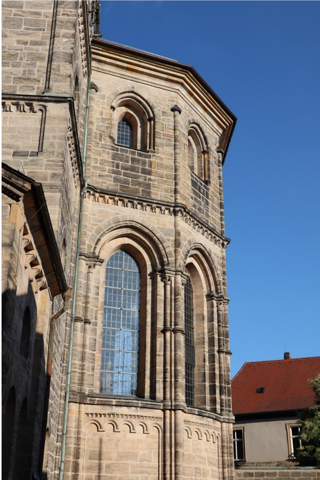
Abb. 59: Der Fassadendekor der Bamberger Westapsis ist ebenfalls spätromanisch. Nur die großen spitzbogigen Fenster lassen erkennen, dass das Chorgewölbe im Inneren dem frühgotischen Vorbild von Laon folgte. Für die Motivation der relativ kleinen oberen Fensterreihe gibt es derzeit keine allgemein akzeptierte Erklärung. Große Apsiden mit zwei Fensterreihen waren ein typisches Element der normannischen Architektur. Mehrere derartige Apsiden existierten darum in Laon, aber auch bei St. Theodor in Bamberg. Die mehrfach stufenförmigen Fensterlaibungen sind in dieser Form nicht typisch romanisch oder gotisch. Sie stellen allenfalls eine Weiterentwicklung der Fenster von Conques und Toulouse dar. Möglicherweise weisen sie jedoch stattdessen auf byzantinische Vorbilder hin, wie beispielsweise La Martorana in Palermo. Die obere Fensterreihe der Bamberger Westapsis mit ihren kleinen Fenstern erinnert etwas an den Tambour von La Martorana.
