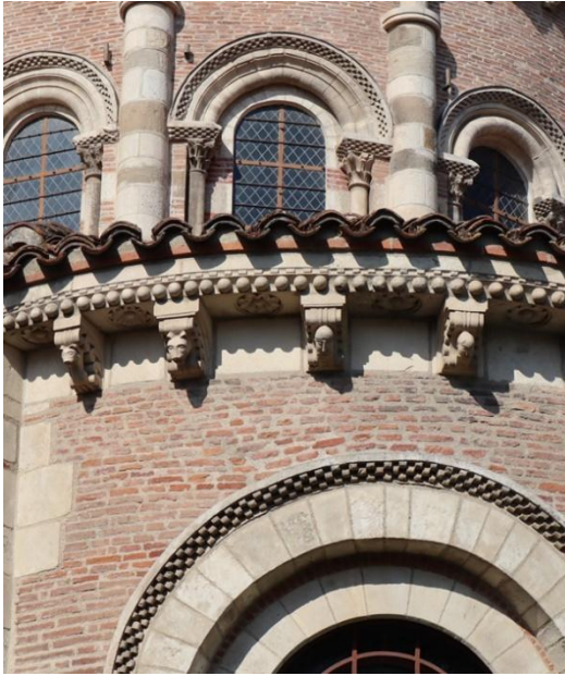
Abb. 33: Zierkugeln am Traufgesims einer Radialkapelle von Saint-Sernin in Toulouse (links). Bei diesen Kugeln handelt es sich um moderne Rekonstruktionen. Ähnliche Zierkugeln aus der Bauzeit existieren aber noch an diversen Gesimsen im Chorumgang. Insbesondere in Südwestfrankreich (Saintonge, Poitou) und in der nordfranzösischen Frühgotik wurden die Zierkugeln durch blütenartige Gebilde mit vier strahlenförmigen Blättern ersetzt. Diese stellen eine Mischform aus Sternen und Blüten dar. Ein gutes Beispiel hierfür befindet sich am Nordportal von Saint-Nazaire in Carcassonne (rechts).
