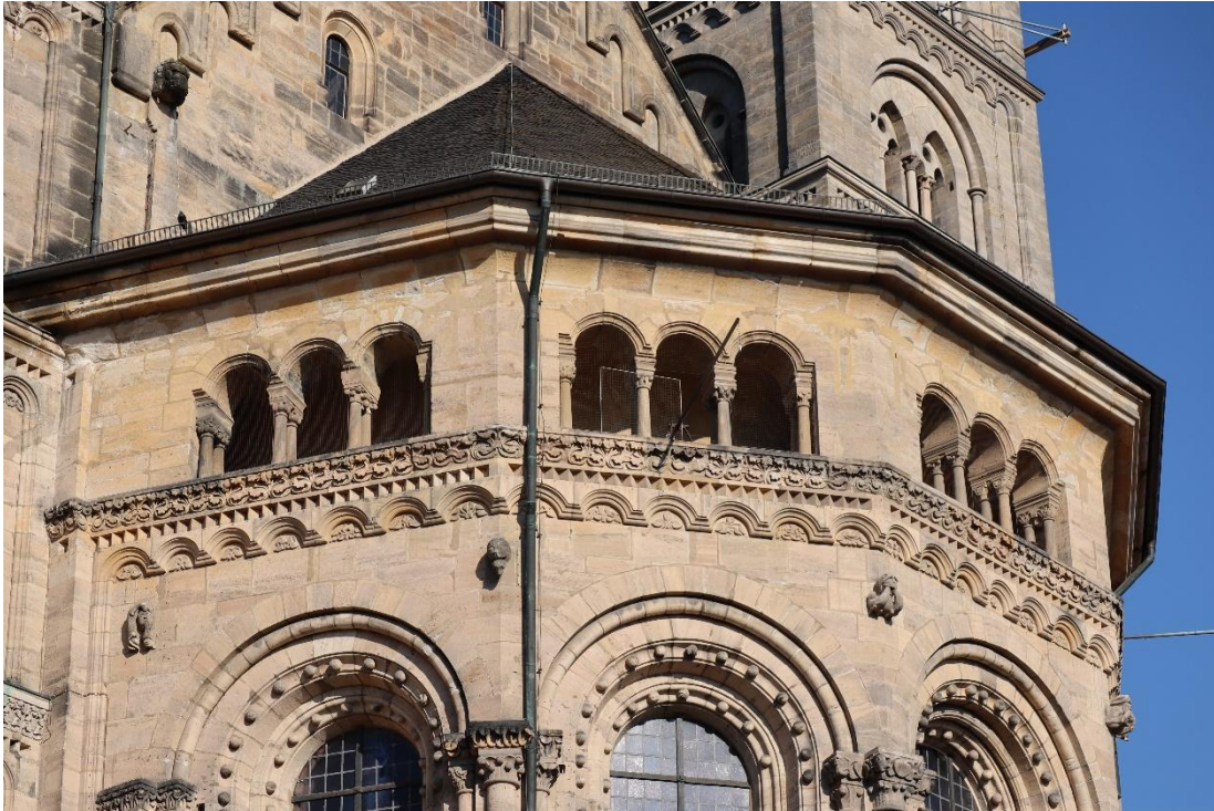
Abb. 5: Zwerggalerie der Bamberger Ostapsis mit Doppelsäulen in den Fenstern. In untypischer Weise stehen auch am linken und rechten Rand der Koppelfenster Säulen. Darunter befinden sich ein Blatt- und Zahnfries, ein profiliertes Bogenfries mit Blattornamenten in den Bogenfeldern sowie Figurenmasken als Kragsteine. Der Bogenfries des Giebels des Langhauses (oberer Bildrand) folgt dem Prinzip des gebrochenen Stabes, wie schon zuvor der Zickzackbogen des Westportals von St. Theodor in Bamberg.
