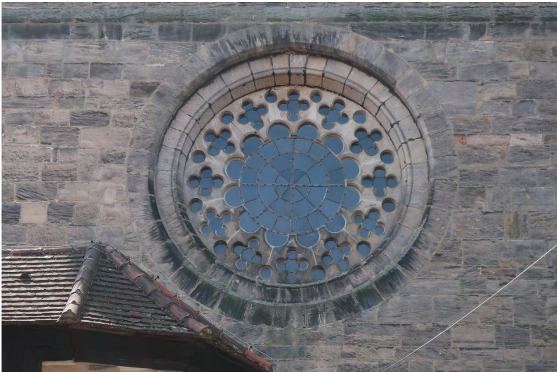
Abb. 58: Nordquerhausrose des Bamberger Doms mit Oculi und zwölf Nasen im Zentrum sowie Plattenmaßwerk im Außenring. Das Plattenmaßwerk besteht aus Vierpässen und kleinen Oculi. Die Bamberger Rose stellt ein nahezu identisches Abbild der Obergadenfenster von Chartres dar. Ein einfacherer Vorläufer existiert im Kreuzgang der Kathedrale von Laon.
