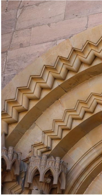
Abb. 37: Das dreiteilige Grundmuster aus Conques oder Toulouse, bestehend aus Profilstufe, Kehlung und separiertem Rundstab war auch maßgeblich für die Ausprägung der Zickzackbögen der Bamberger Adampforte (links) sowie für die Bamberger Veit'spforte (Mitte) und ihre flankierenden Blendarkaden (rechts).
