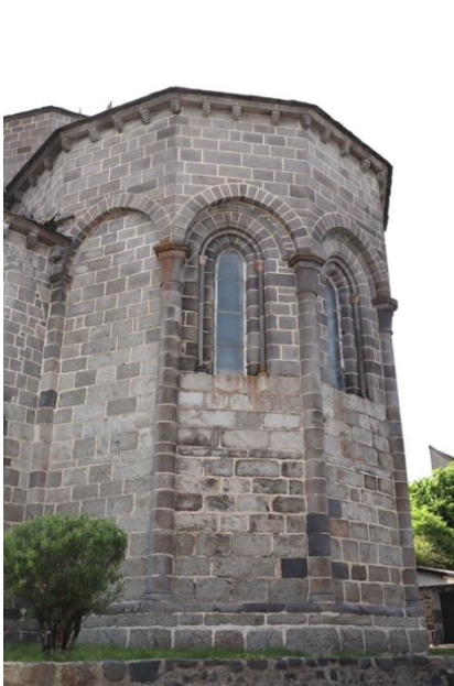
Abb. 56: Weitere polygonale Apsiden der Auvergne mit Blendarkaden in Herment (links) und Roffiac (rechts). Bei der Apsis von Herment haben die Fenster eingestellte Säulen und Rundstäbe, wie beim zentralen Apsisfenster in Bamberg. In Meymac (Limousin) befindet sich eine ähnliche Apsis, bei der sich in jeder Polygonalfläche ein Fenster befindet, wie ebenfalls in Bamberg. Die Apsis von Roffiac (rechts) ist ein typisches Beispiel für einige weitere polygonale Apsiden der Auvergne. Bei diesen sind Polygonflächen und Arkadenbögen nicht kongruent. Es existieren mehr Arkadenbögen als Polygonflächen. Doch auch in Roffiac stehen die Säulen der Blendarkaden auf einem Gesims unterhalb der Sohlbänke der Apsisfenster.
