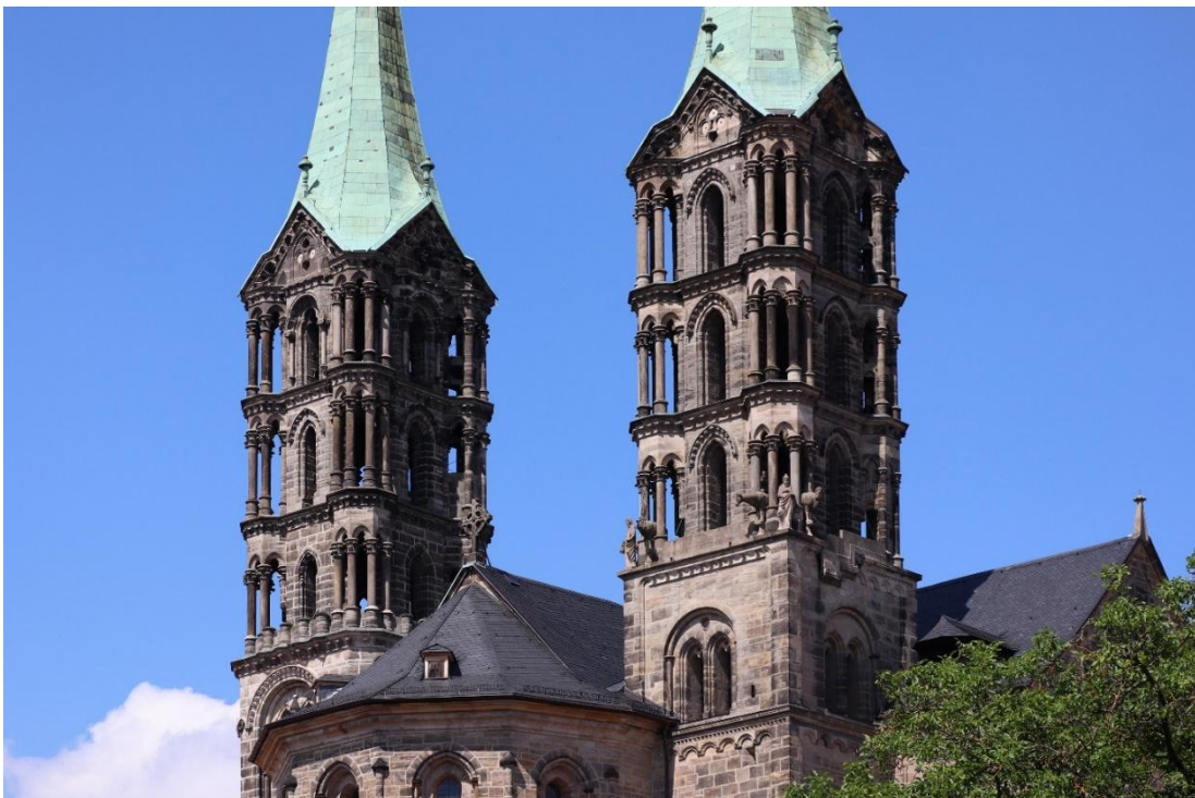
Abb. 63: Westtürme des Bamberger Doms. Der Übergang der Tabernakel von romanischer Massigkeit zu gotischer Luftigkeit erfolgt am Südturm (rechts) schrittweise von Geschoss zu Geschoss. Dagegen sind die Tabernakel des mittleren Geschosses des Nordturms (links) bereits wie am oberen Geschoss ausgeprägt. Das ungewöhnlich große Fenster unter den Tabernakelgeschossen des Südturms (rechts) hat einen Oculus, der im Gegensatz zu den meisten anderen Turmfenstern nur als scheibenförmige Vertiefung angedeutet ist.
