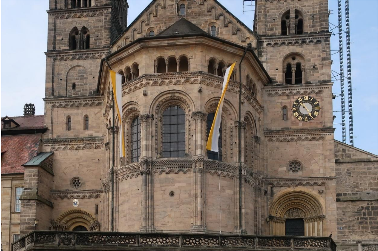
Abb. 2: Ostbau des Bamberger Doms mit Adams- und Gnadenpforte in den Türmen. Die Apsis ist nur oberhalb der Sohlbänke der Fenster polygonal. Die Türme haben geschossartige Gliederungen durch Bogenfriese nach dem Vorbild des Doms zu Speyer oder des zeitlich früheren Campanile von Pomposa.
