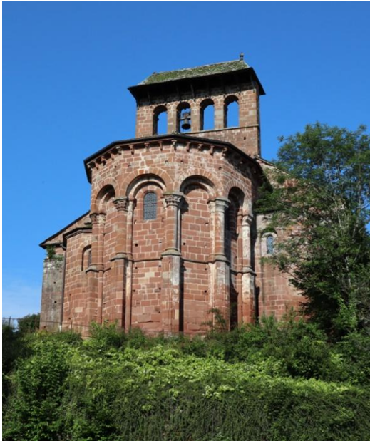
Abb. 55: Die nahezu identisch strukturierten Apsiden von Saint-Hilarian-Sainte-Foy in Perse (Espalion, links) und Bamberg (rechts). Beide Apsiden sind (weitgehend) polygonal und haben große Blendarkaden, deren Säulen an den Polygonkanten positioniert sind. Ein Gesims unterteilt die Apsiden vertikal. Die Säulen der Blendarkaden stehen mit ihren Basen auf diesem Gesims. Besonders charakteristisch sind die in die Blendarkaden eingestellten Säulen und Rundstäbe, die auch unterhalb des trennenden Gesimses auftreten. Diese zusätzlichen Säulen und Rundstäbe sind eine Besonderheit, die man in dieser Form nur an den Apsiden von Perse und Bamberg findet.
