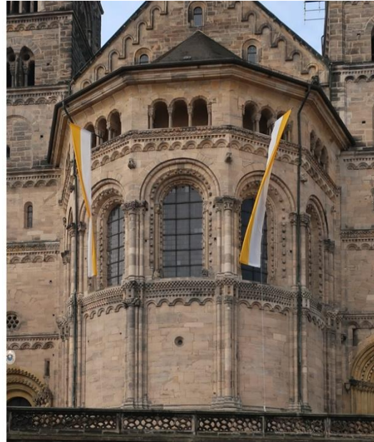
Abb. 55: Die nahezu identisch strukturierten Apsiden von Saint-Hilarian-Sainte-Foy in Perse (Espalion, links) und Bamberg (rechts). Beide Apsiden sind (weitgehend) polygonal und haben große Blendarkaden, deren Säulen an den Polygonkanten positioniert sind. Ein Gesims unterteilt die Apsiden vertikal. Die Säulen der Blendarkaden stehen mit ihren Basen auf diesem Gesims. Besonders charakteristisch sind die in die Blendarkaden eingestellten Säulen und Rundstäbe, die auch unterhalb des trennenden Gesimses auftreten. Diese zusätzlichen Säulen und Rundstäbe sind eine Besonderheit, die man in dieser Form nur an den Apsiden von Perse und Bamberg findet.
