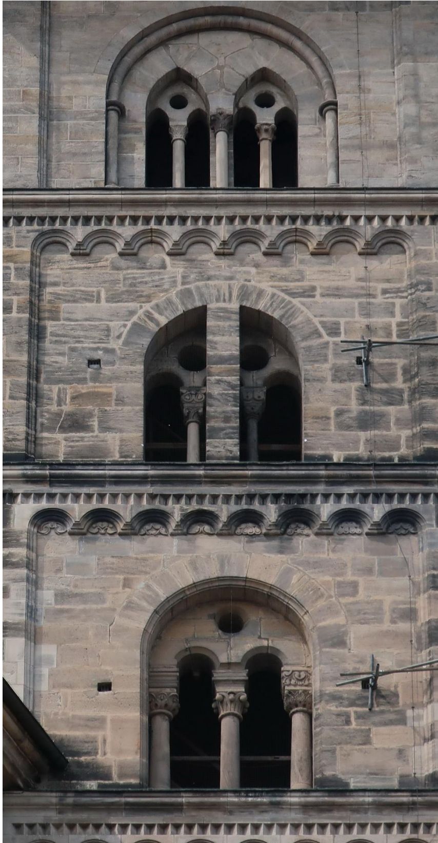
Abb. 26: Nordostturm des Bamberger Doms mit unterschiedlich ausgestalteten Koppelfenstern. Diese sind von Blendbögen überfangen und haben Oculi in den Zwickeln. Die Anzahl der Fensteröffnungen wächst mit zunehmender Geschosshöhe, wie zuvor bereits in Pomposa. Das unterste Fenster repräsentiert am ehesten den klassischen Typus. Die beiden äußeren Säulen des unteren Fensters folgen französischen oder spanischen Vorbildern. Im obersten Fenster sind Rundbögen und Spitzbögen kombiniert. Die dort in den Blendbogen eingestellten Säulen und der Rundstab sind typisch für Fenster der Normandie und der Frühgotik.
