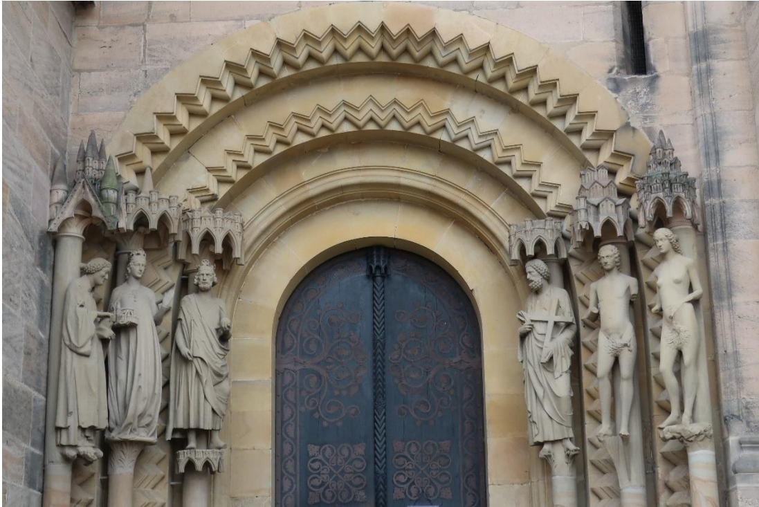
Abb. 24: Bamberger Adamspforte mit Zickzackbögen im stufenförmigen Portalgewände. Die Zickzackbögen sind eine Kombination aus gebrochener Kehlung und gebrochenem Stab nach dem Vorbild des Südportals von Conques. Die Gewändefiguren und ihre Säulen wurden erst nachträglich eingefügt (um 1230). Das Portal hat kein Tympanon. Es erinnert in seiner Grundstruktur an das schmucklose Westportal von Speyer, aber auch an das ehemalige Westportal von St. Theodor in Bamberg.
