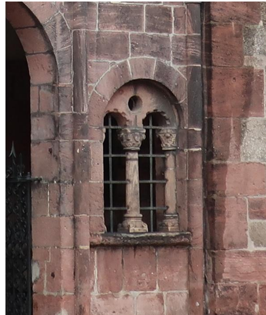
Abb. 40: Eines der unteren Turmfenster der Bamberger Osttürme (links) und eines der Narthexfenster von Sainte-Foy in Schlettstadt (rechts). Es existieren keine weiteren Koppelfenster, die den älteren Bamberger Turmfenstern ähnlich nahe stehen wie die Fenster aus Schlettstadt. Weitere ähnliche Fenster haben entweder keinen Oculus, keine Außensäulen oder in der Mitte eine Doppelsäule. Die Archivolten der Bamberger Turmfenster haben sogar die gleiche Kehlung wie in Schlettstadt. Es fehlen nur die dort eingestellten Rollen. Stattdessen haben die Bamberger Fenster ornamentale Kämpfer über den Kapitellen, wie in Conques und Südfrankreich üblich.
